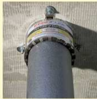
Przykład montażu kolnierza PYROPLEX® PPC4
